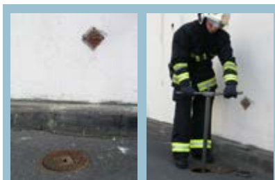
Organe de coupure générale (OGC) sous trottoir BP robinet ¼ de tour
