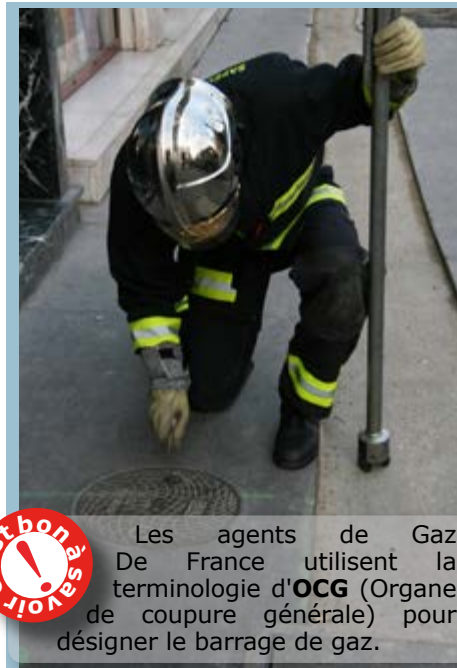
Barrage général en façade MP coup de poing, robinet ¼ de tour ou manivelle
