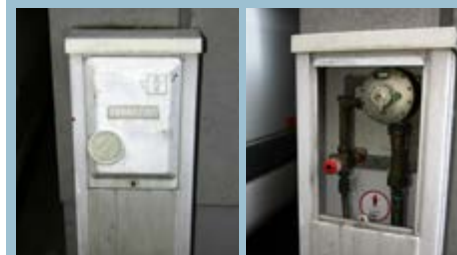
Barrage général en façade MP coup de poing, robinet ¼ de tour ou manivelle
